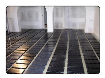
Bei der Janßen-Fußbodenheizung im Nassaufbau ist das wasserführende Heizrohr mit den aufgesteckten Aluminium-Wärmeverteilern durch robuste Kunststoff-Heizflächenabdeckungen komplett vom Estrich getrennt.
